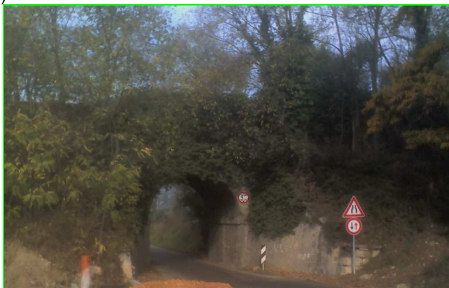
Figura 7 – Progno di Val Sorda: ponte canale
