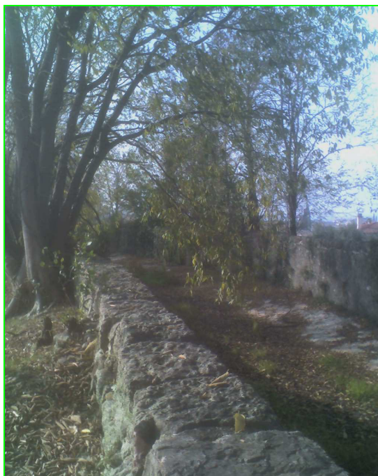
Figura 8 - Progno di Val Sorda: tratto pensile posto poco a valle del ponte canale.
